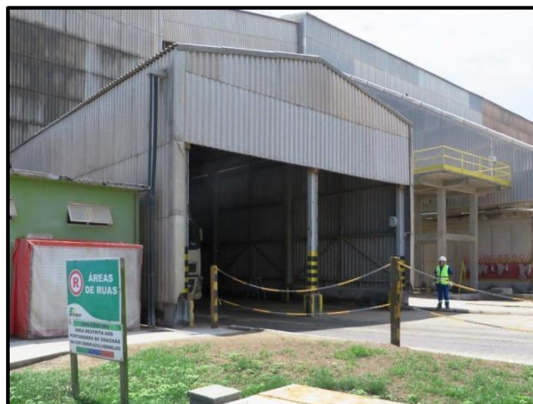
Figura 6 – Tulha de carregamento dos caminhões.
