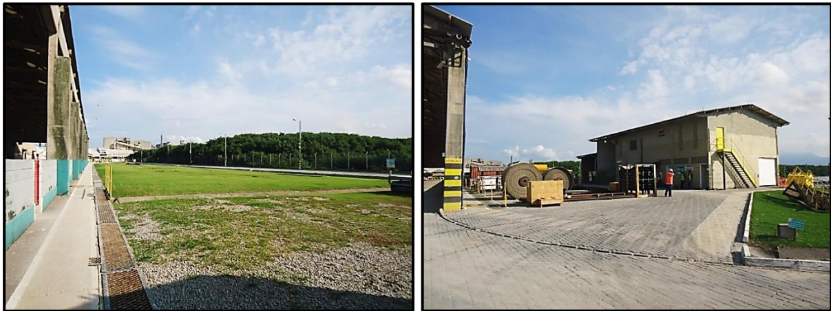
Figura 11 – A direita o local onde será inserido o novo armazém e a esquerda uma oficina que será demolida para dar lugar à novas estruturas.
