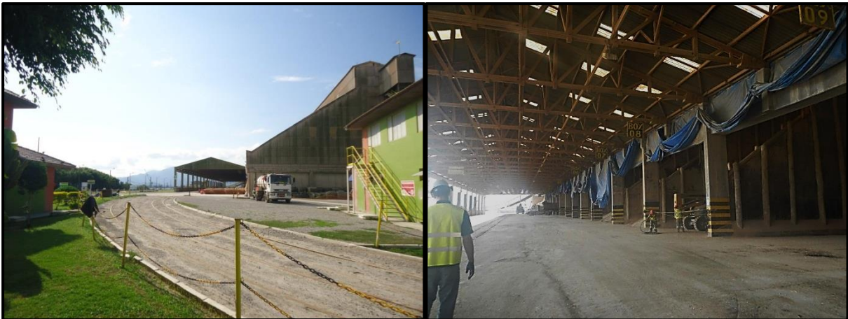
Figura 5 – Vista externa e interna do atual armazém do terminal.
