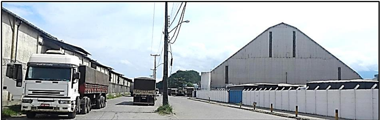
Figura 16 - Estruturas e edificações relacionadas a atividades portuárias e correlatas.
